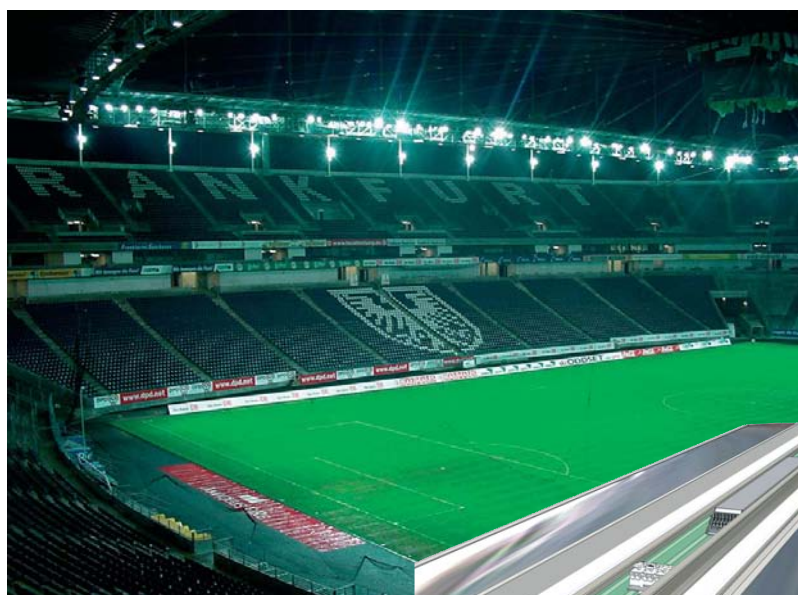
WM-Stadion in Frankfurt (Quelle: Siteco)
